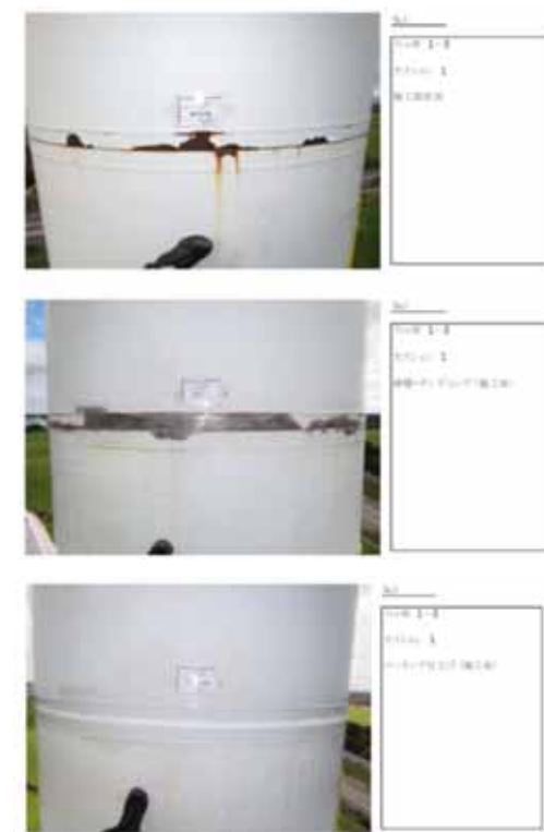
図3-5. 1-3号機フランジ部補修 2022.10月
