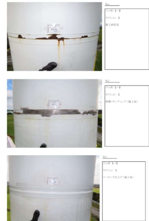
図3-5. 1-3号機フランジ部補修 2022.10月
