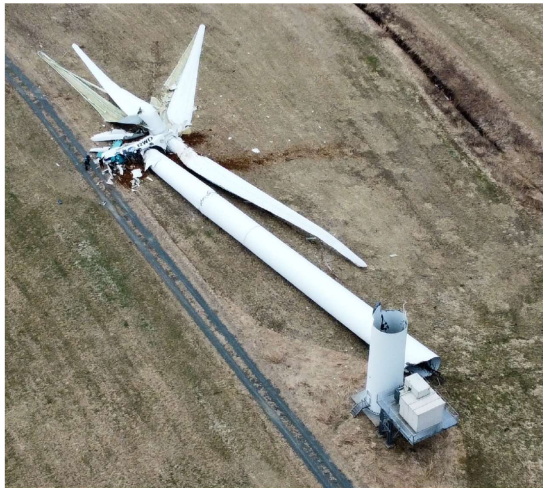
図1-4. 事故時の上空からの状況写真
