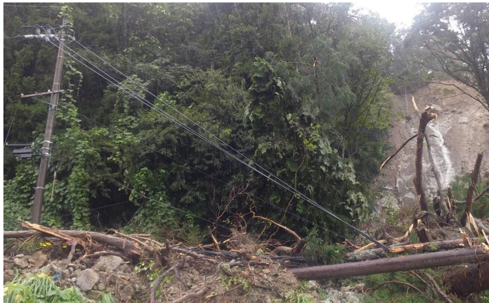
被害状況（電柱倒壊）
