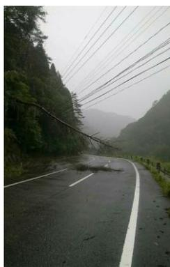
配電：支持物折損、電線断混線（大分県）
