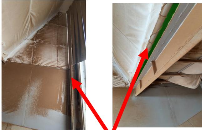
受入ホッパフードと飛散防止シートの間隙を塞ぐ。
