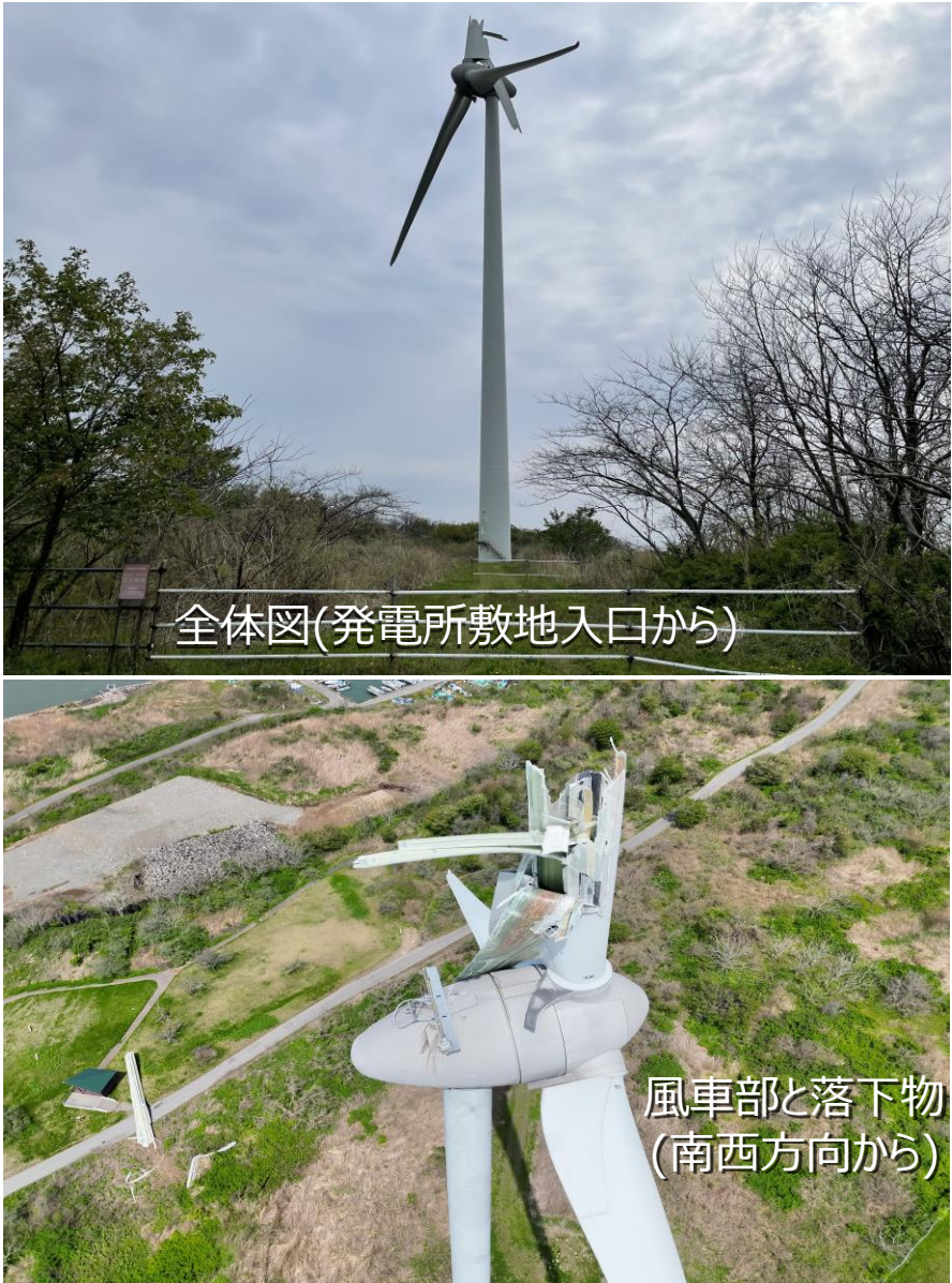
図1-1 破損した風車の状況
