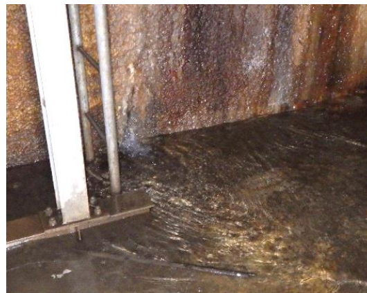
鉄管弁室漏水状況 (R6. 1. 23)
