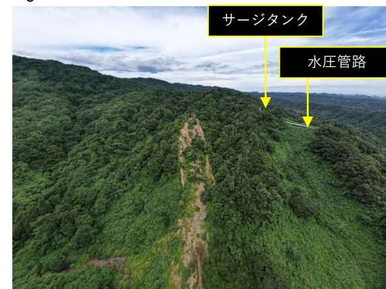
サージタンク南西方向の斜面崩壊 (R4. 8. 16)
