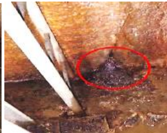
鉄管弁室漏水状況 (R6. 12. 3)
