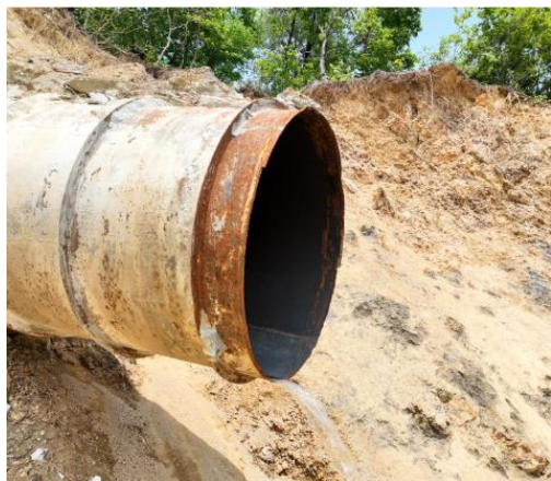
破断箇所（上:正面、下:側面、第2回調査時） （単管⑥下流端）
