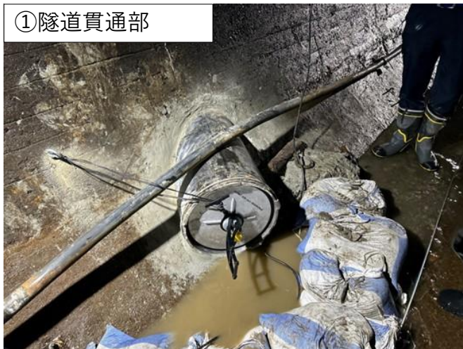
② 隧道と接続（推進工）
