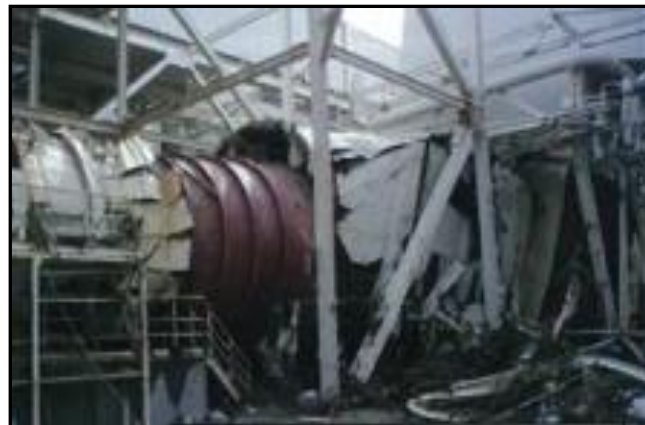
(写真2) 通風機の被害
