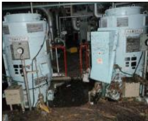
(写真1) 復水ポンプ（電動機）の被害
