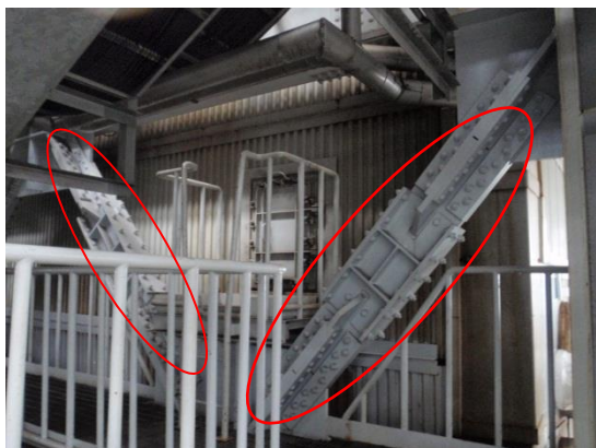
ボイラ支持架構の補強例
