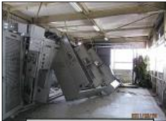
(写真3) 制御盤の被害
