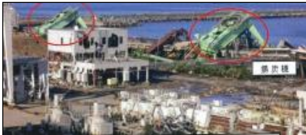
(写真4) 揚炭設備の被害
