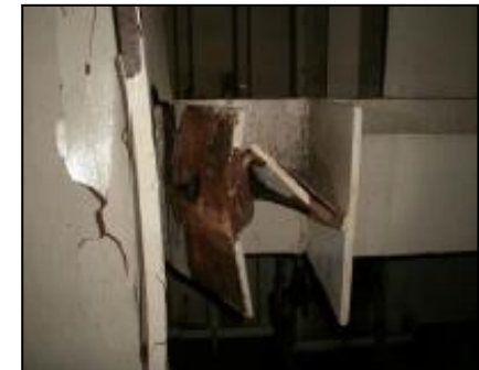
(写真3) ボイラー鉄骨の変形
