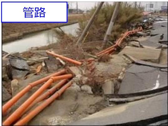
【東北地方太平洋地震による地中送電設備被害例】
