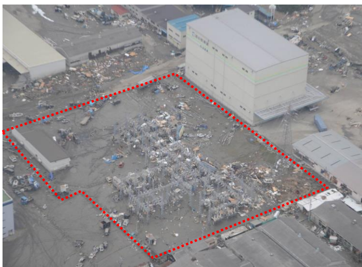
【東北地方太平洋地震による変電所被害例】
