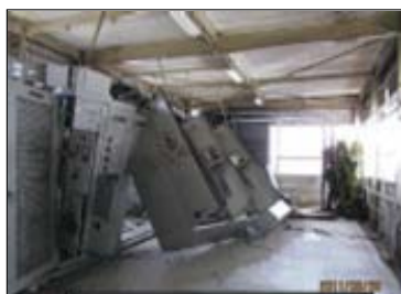
(写真3)制御盤の被害
