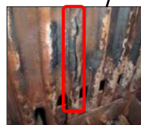
ボイラーチューブ の修理箇所
