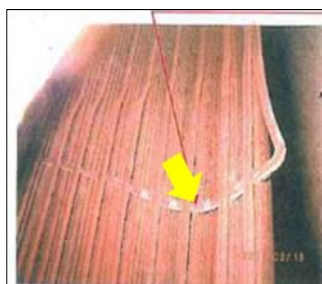
(写真2)クーリングスペーサー管の変形
