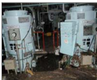
(写真1)復水ポンプ(電動機)の被害
