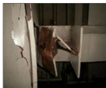
(写真3)ボイラー鉄骨の変形
