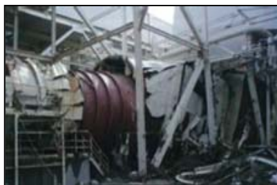
(写真2)通風機の被害
