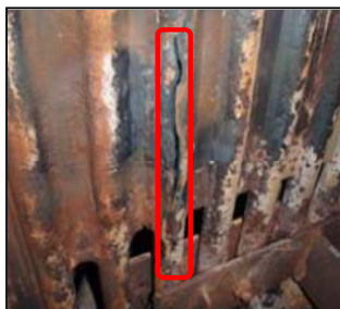
(写真1)ボイラーチューブの破孔
