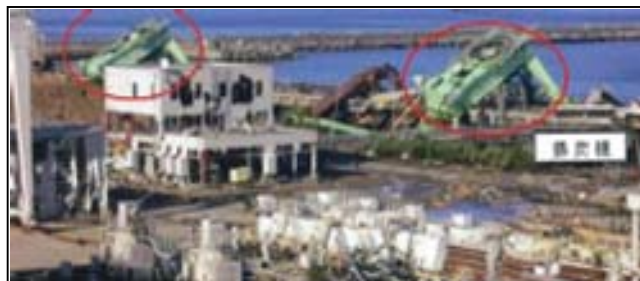
(写真4)揚炭設備の被害
