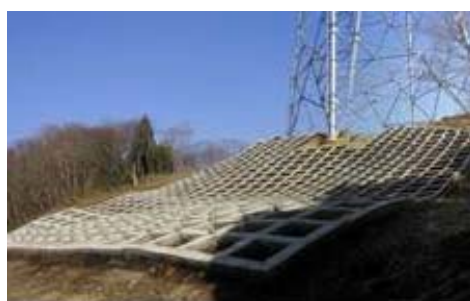
法面保護工の実例 (フリーフレーム工法)
