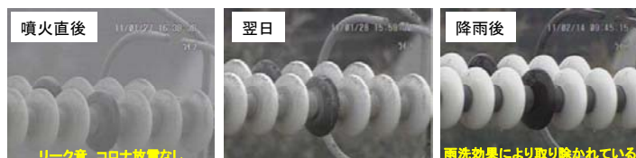
<ITVカメラで確認された雨洗効果の状況>
