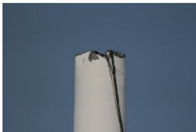
写真1 ナセル落下とタワーの破断状況
