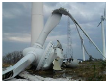
写真1 ナセル落下とタワーの破断状況
