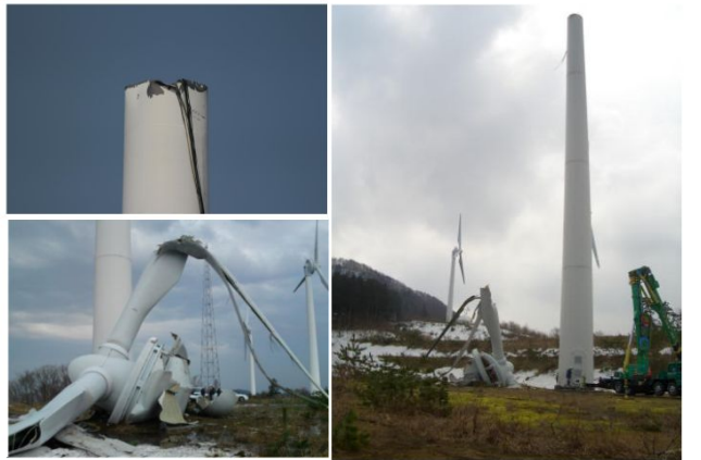
写真1-1 ナセル落下とタワーの破断状況
