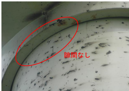
図 3-11 ナセル(ロータヘッド側隙間)
