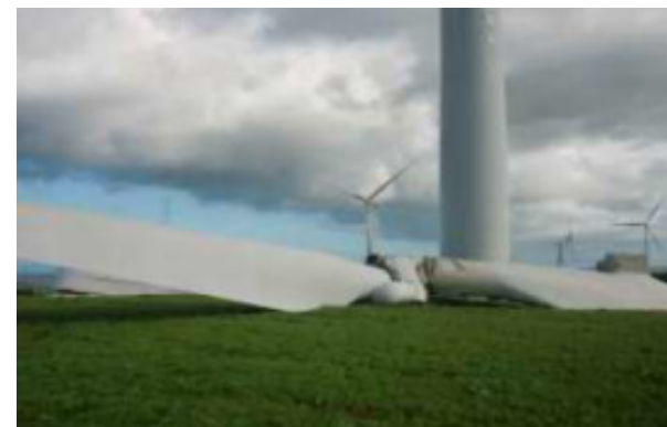
図-3 ロータハブ落下状況
