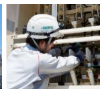
高圧機器の点検
