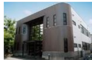
6kV級で受電する事務所等
