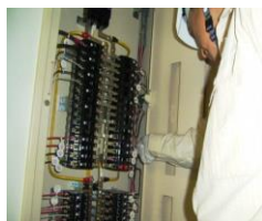
引込設備の点検
