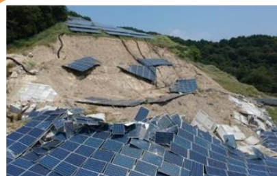
太陽電池パネルの飛散
