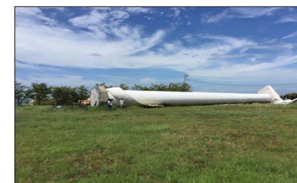
風力発電設備倒壊事故（2018年8月、淡路市）
