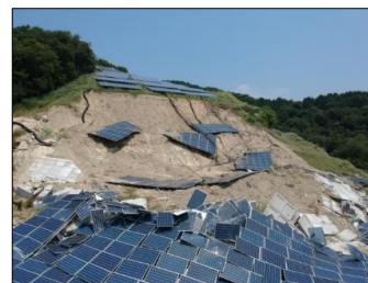
太陽光パネル崩壊事故（2018年7月、姫路市）
