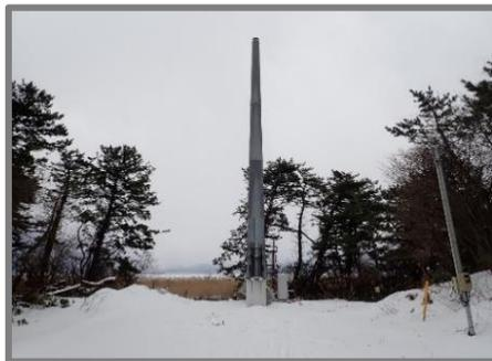
・2019年1月、青森県つがる市において、小形風力発電設備（20kW未満）のナセルがタワー基部に落下する事故が発生。【ブレード回転直径:13.1m ハブ高さ:20m】
