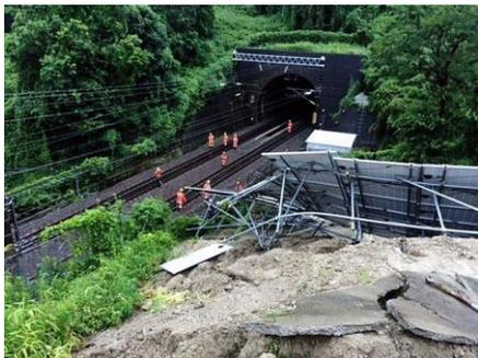
・2018年7月の西日本豪雨の発生時に、神戸市において、小出力の太陽電池発電設備（50kW未満）の崩落事故が発生。安全確認のため、山陽新幹線の運転を一時見合わせ。
