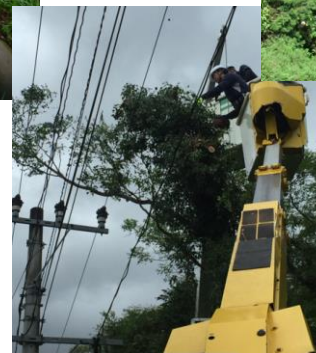
倒木除去作業
