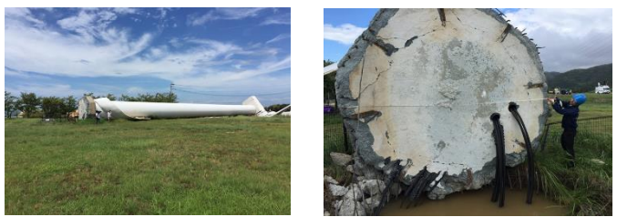
<風力発電所 風車倒壊事故>
