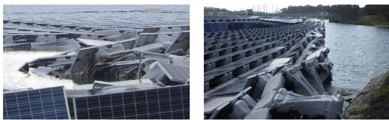
<水上設置型太陽電池発電所 発電設備転倒・破損事故>
