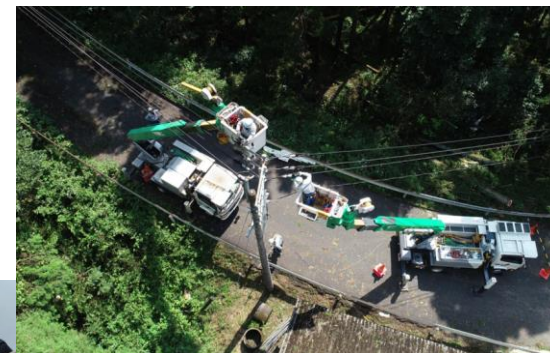
ドローンで撮影した 復旧作業の様子
