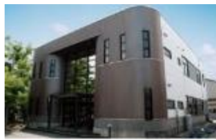
6kV級で受電する事務所、工場等
