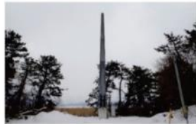
小形風力の設備落下
