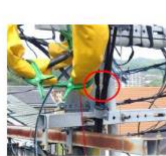
写真2 事故ケーブルの設置状況
