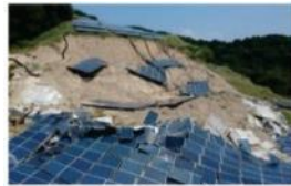
太陽電池パネルの飛散
