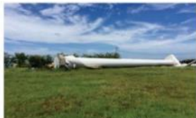
風力発電設備の倒壊
