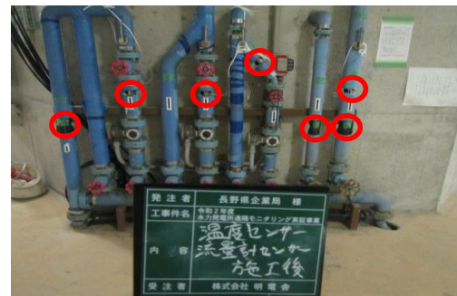
流量及び温度センサー設置状況
