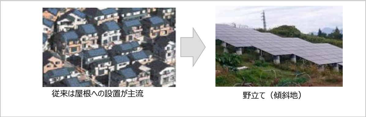
＜太陽光発電設備の設置形態の変化＞
