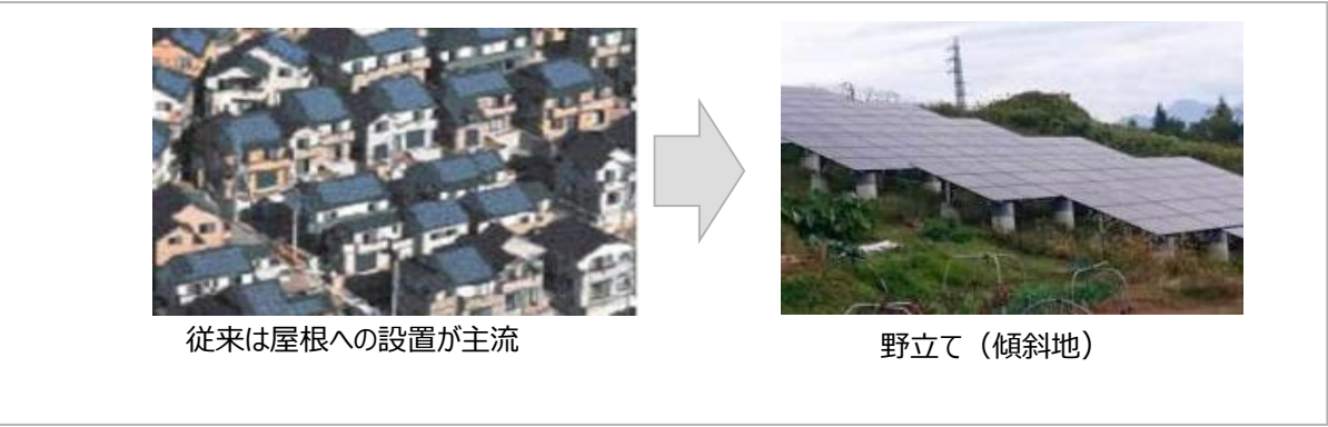
＜太陽光発電設備の設置形態の変化＞
