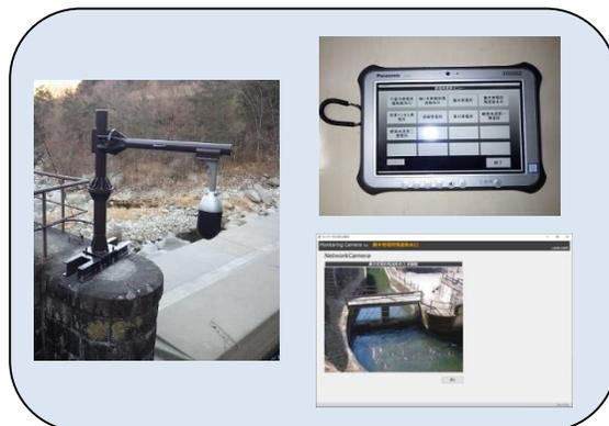
山梨県：ネットワークカメラとタブレット端末を用いた取水口の遠隔監視
