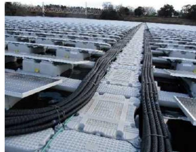
図2:配管に納めた配線の例
