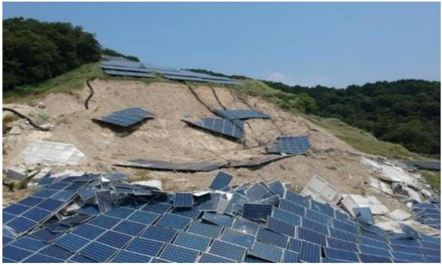
太陽電池発電設備に係る土砂崩落
