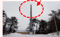
<風車の羽根の脱落>
