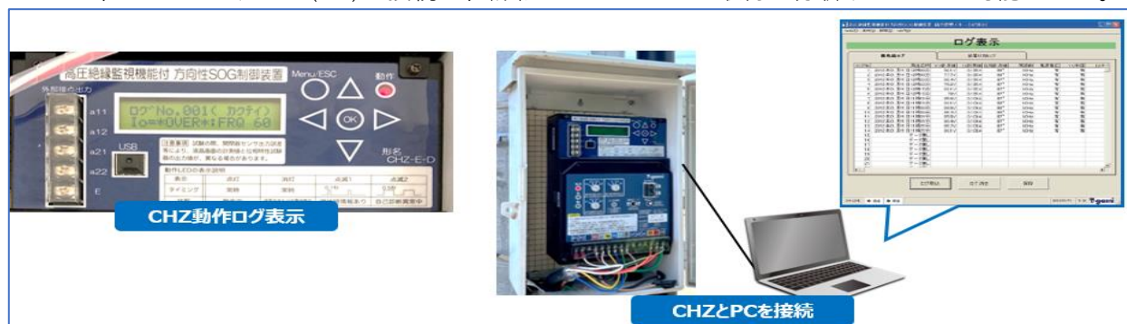
図 10 CHZ の動作ログ表示と PC 接続によるデータ抽出
