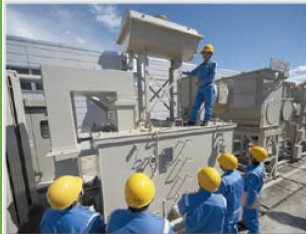
特高受変電システム
