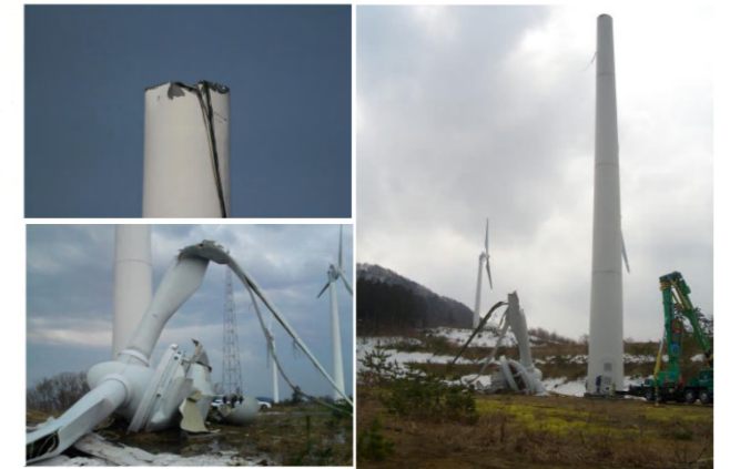
写真1-1 ナセル落下とタワーの破断状況
