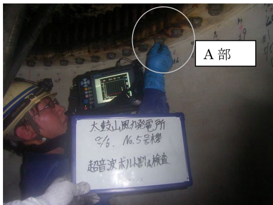
a) 探傷状況全景
