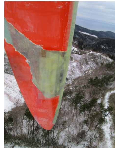
写真①-7 (緊急処置完了)
