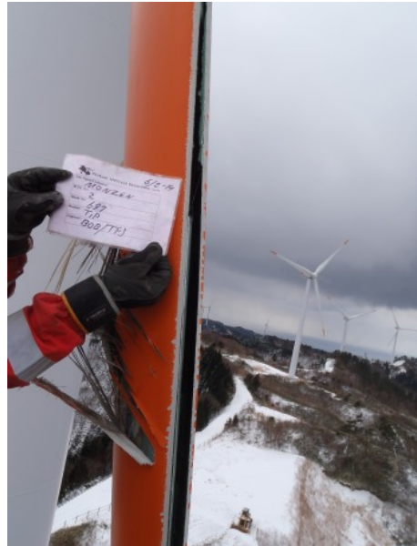
写真①-3 (損傷部確認)
