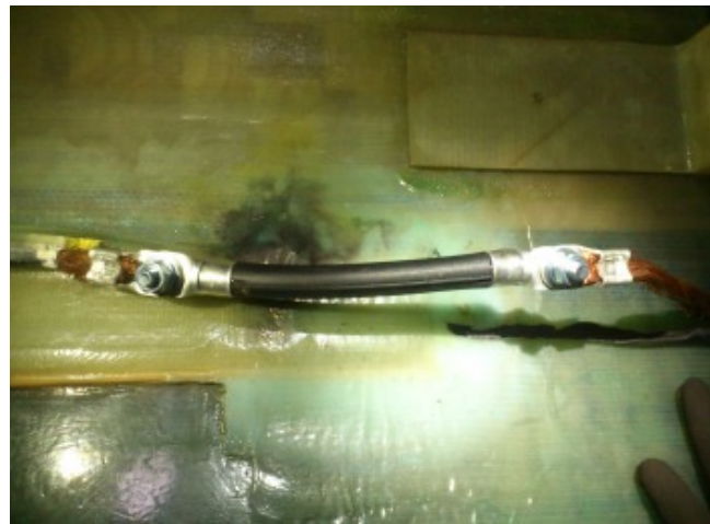
写真②-3 (ダウンコンダクタ補修)
