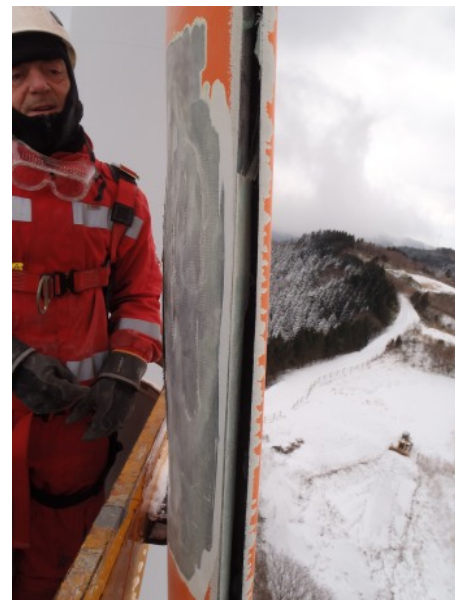
写真①-5 (補修中)
