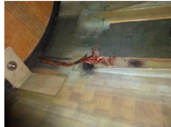
写真②-2(ダウンコンダクタ接写)
