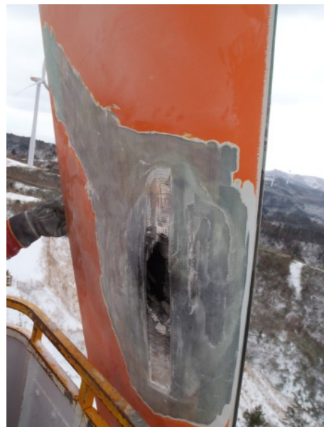
写真①-4 (補修中)
