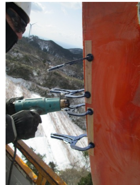
写真①-6 (補修中)
