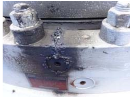
2) (Bサイトで確認されたグリス漏れ)
