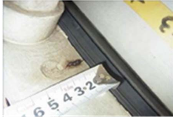
1) (A風力発電所で確認されたクラック)
