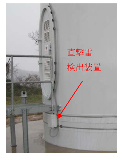
図 3 直撃雷検出装置
