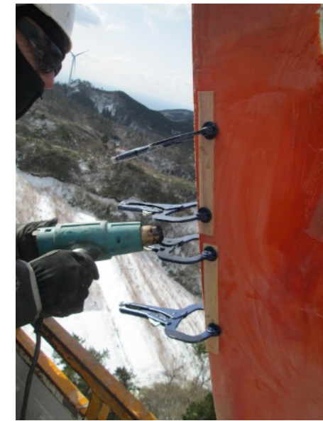
写真①-6 (補修中)
