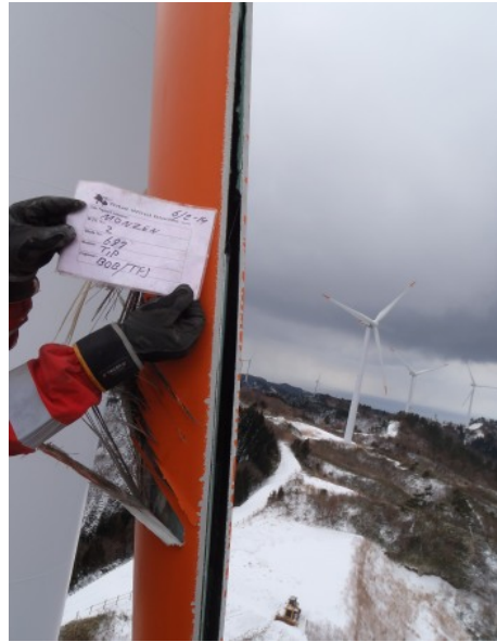
写真①-3 (損傷部確認)
