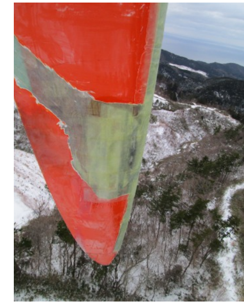
写真①-7 (緊急処置完了)
