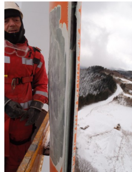
写真①-5 (補修中)
