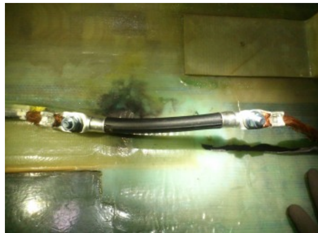
写真②-3(ダウンコンダクタ補修)
