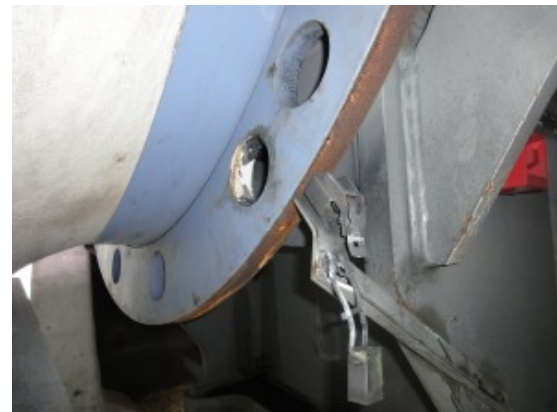
写真③-1(スリップリング接触部脱落)
