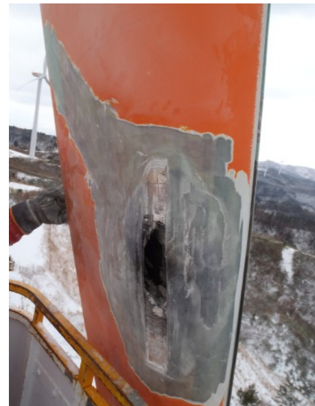
写真①-4 (補修中)
