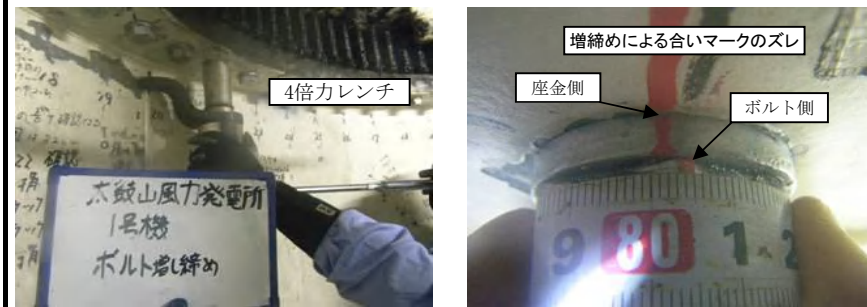
写真3-1 増締め実施状況(締付日:H26.3.11、増締め日:H26.4.17)
