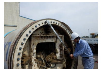
写真3-2 事故機ボルトの調査状況
