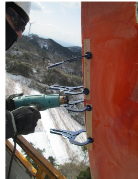
写真①-6 (補修中)
