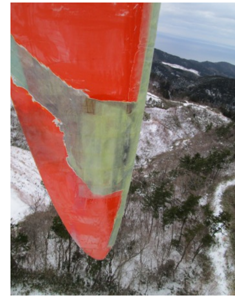
写真①-7 (緊急処置完了)
