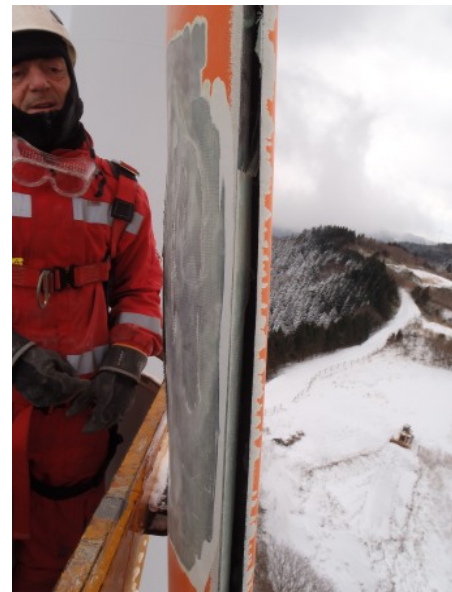
写真①-5 (補修中)
