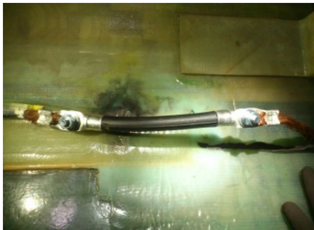
写真②-3(ダウンコンダクタ補修)
