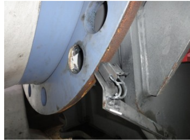
写真③-2(スリップリング接触部取付け)
