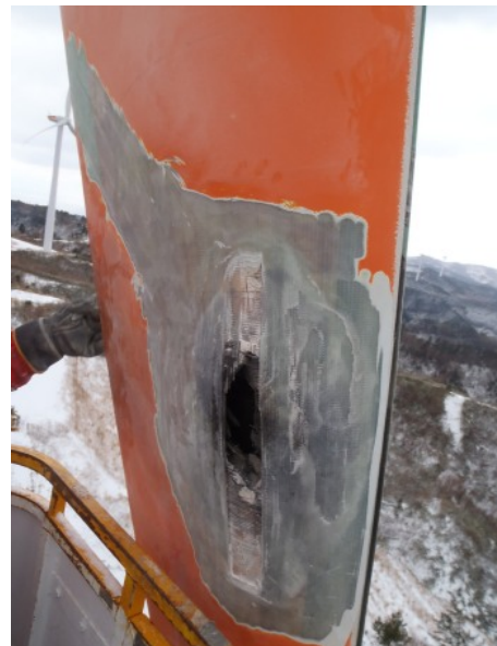
写真①-4 (補修中)
