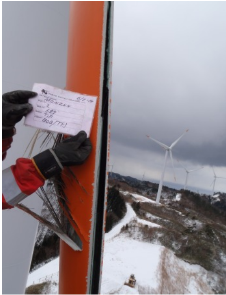
写真①-3 (損傷部確認)
