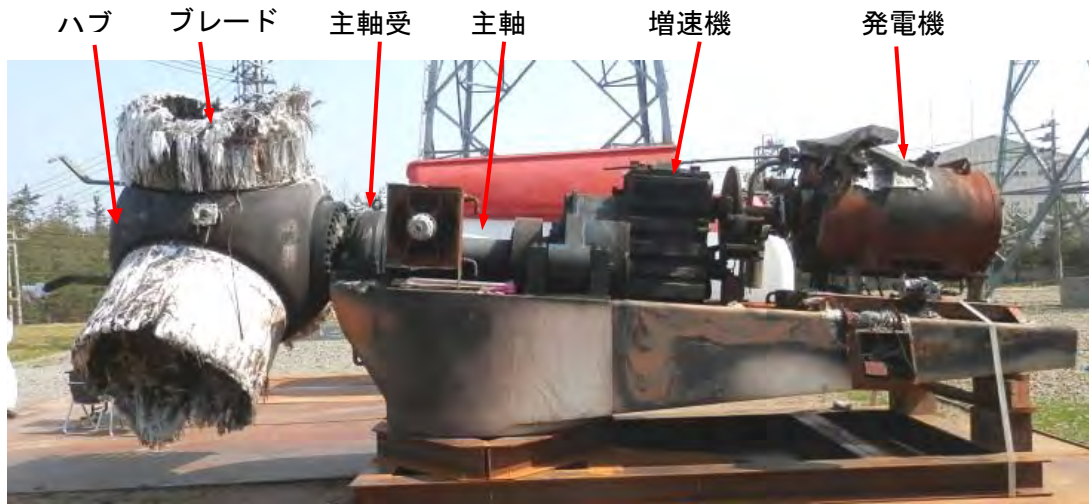
写真3 ハブ・ナセル損傷状況（地上へ取り下ろし後）
