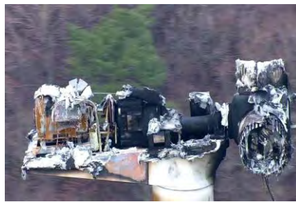
写真1 ハブ・ナセル破損状況
