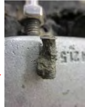
写真3 ロッド先端の状況(※1) (※1) ロッドはレセプタブロックねじ込み部分を切断し、新品のレセプタブロックを仮置した状態で撮影
