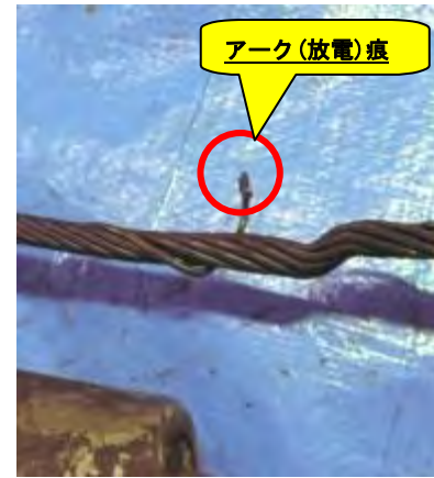
写真9 ダウンコンダクタ（ワイヤー）
