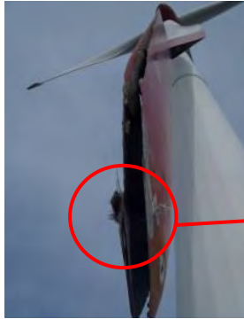
写真1 チップブレーキ裂け目状況
