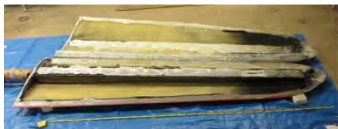
写真6 チップブレーキ内面の状況
