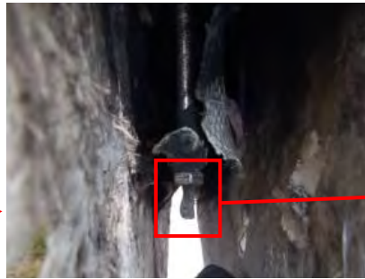
写真2 レセプタブロック取付部 [レセプタブロックが脱落]
