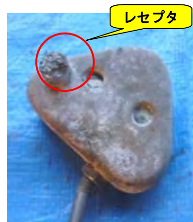
写真7 レセプタブロック(ブレード④)
