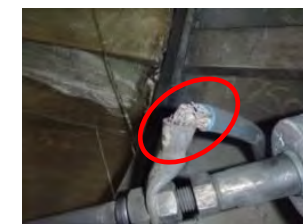
ライトニングケーブル（一部素線溶着、断線）
