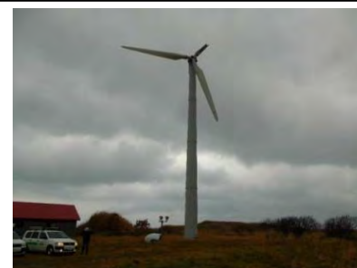
図-3 事故後の風車全景
