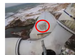
ナセルカバー（損傷ブレードからの空気噴出痕）
