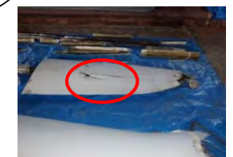
ブレードチップ（放電痕、表面はく離）
