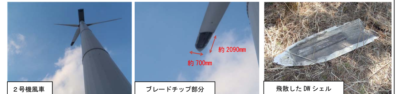
図-6 ブレードチップの破損事故状況、飛散したシェルの状況
