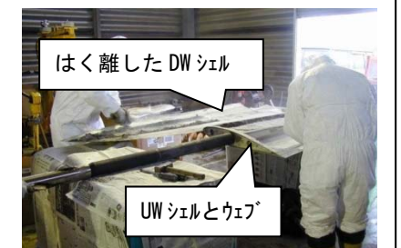
図-8 2002年2月実施の補修の様子
