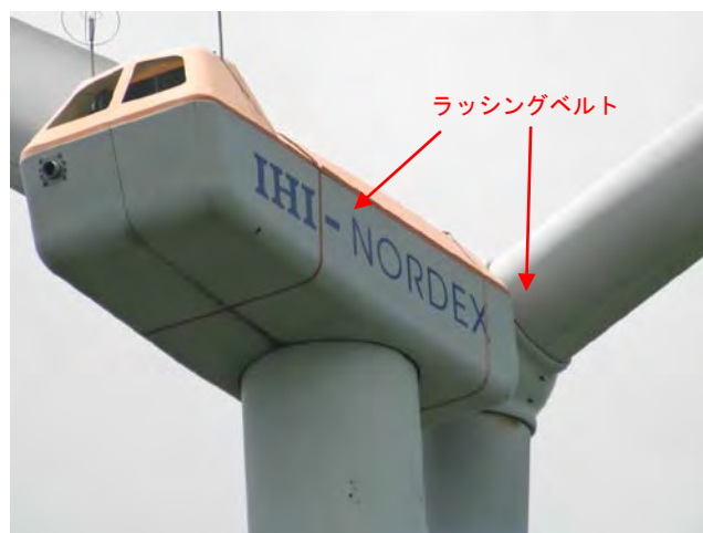
ラッシングベルト装着状況
