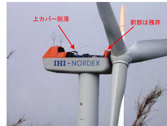
ナセルカバー脱落状況
