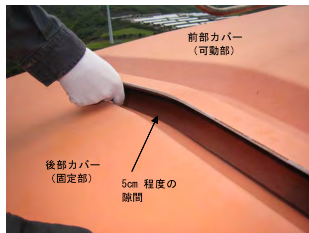
前部カバーと後部カバーの隙間
