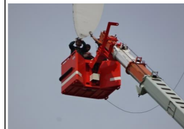
重機を使用したブレードUT検査
