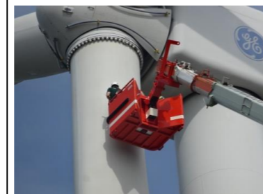
重機を使用したブレードUT検査
