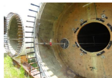
ブレード内部点検蓋
