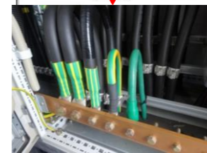
アース線接続部
