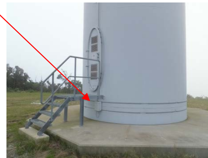
図1 (風車直撃雷検出装)
