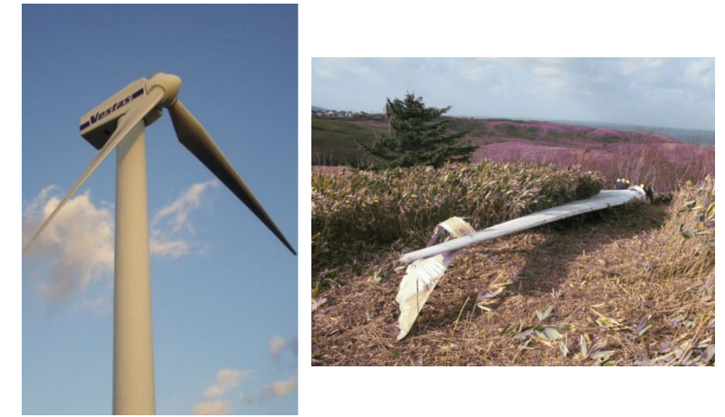
図 1-3 ブレード落下状況
