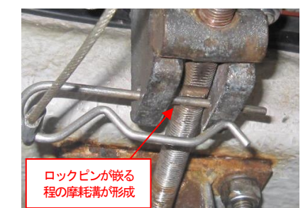
写真12 摩耗溝へのロックピン嵌り状況
