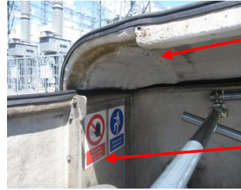
写真14 ナセルハッチが落ち込んだ状態
