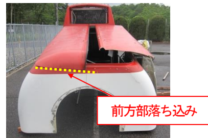
写真13 ナセルハッチ落ち込み状況
