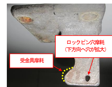
写真11 受金具摩耗の状況
