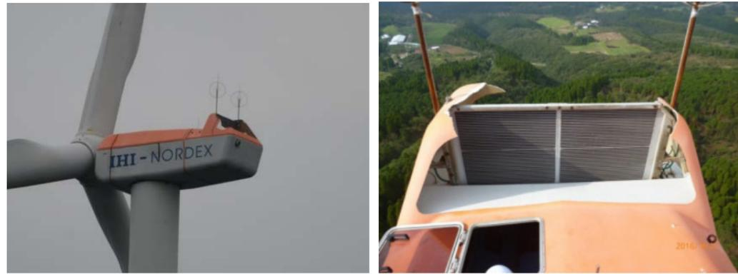
図6 佐多1号損傷状況（ラジエーターカバー損傷例）
