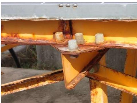
鋼製部分だけでなくアルミフレームとの電食も見受けられる
