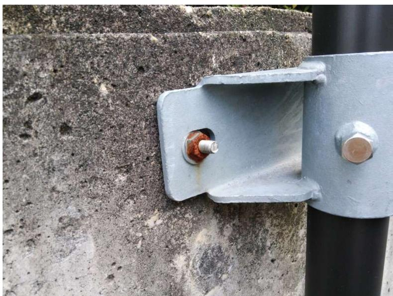
図 7-4 奈良県北葛城郡の環境でステンレスボルトに亜鉛めっきナットが使用された場合の腐食事例
