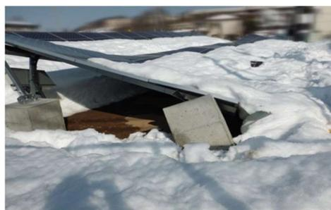
積雪荷重により架台が損傷している。単管架台の支持力不足、強度不足と推察される。
