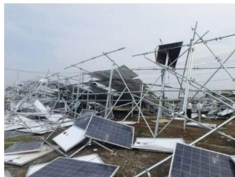
台風によって折損したアルミ製架台。金属部材が脆性的に破損している事例は珍しく、部材の強度不足が原因である。
