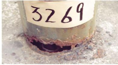
図 7-1 地際部が錆び、杭が開いた状態
