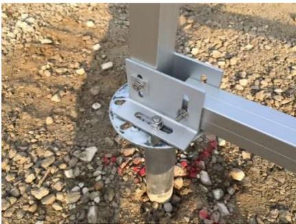
図 6-2 杭頭部のズレ調整金具の例
