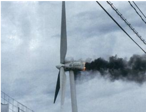
図4 火災事故(発火直後)
